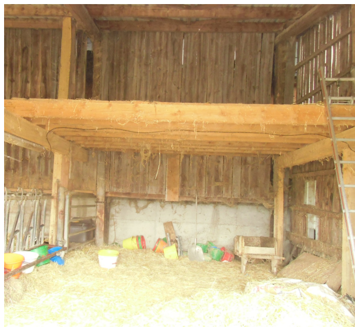
Plancher de paillage.
